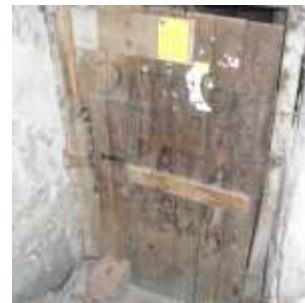
Možda je dobra ideja da cilindar sa unutrašnje strane može da se otvori bez ključa, da nema kvake već rukohvate i da ima interfonsku bravu, tako da se sa spoljne strane otvara isključivo ključem. Naravno kao što je predložio komšija Pirec, na vratima da se pri vrhu i dnu naprave prorezi ili otvoriti sa zavarenom sitnom mrežom kako bi vazduh mogao da cirkuliše.
